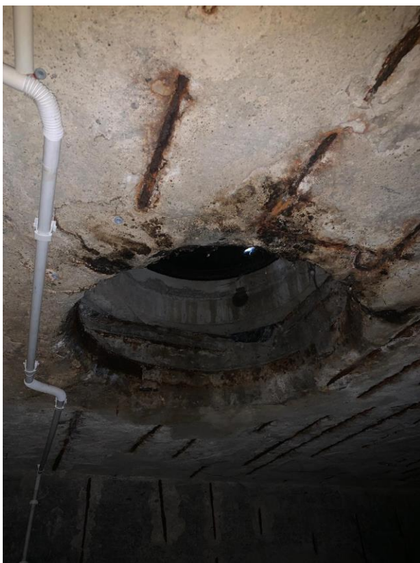
Fot. 4 (Odparzona otulina przy otworze stropu na dziedzińcu)
