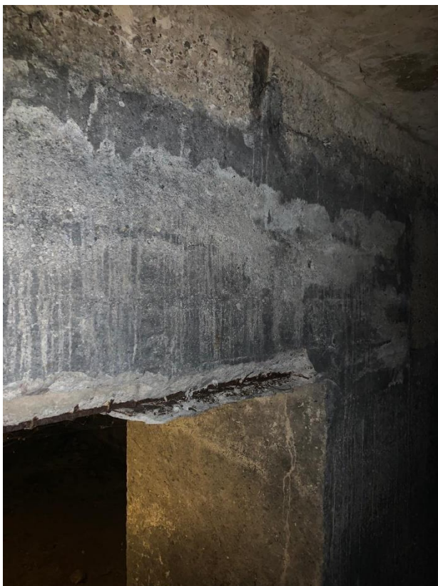
Fot. 5 (Odparzona na podciągu w piwnicy)
